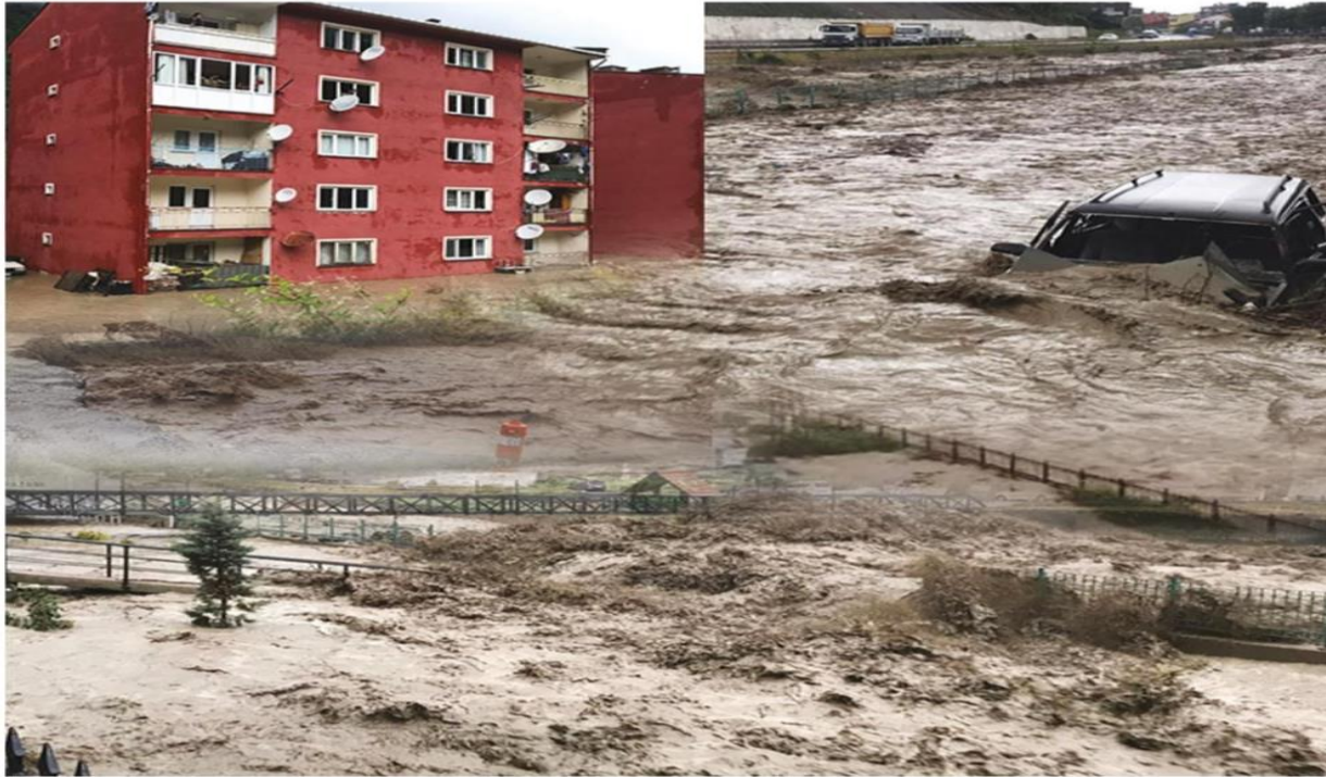
Şekil 3.4 Şiddetli Yağmur sebebiyle oluşan sel (İnebolu)
